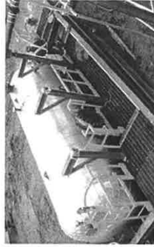
รูปที่ 2-13 ตัวอย่างและการทำงานของ Knock-Out Drum
