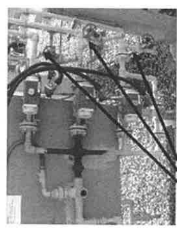
รูปที่ 4-7 ตัวอย่าง Orifice ที่ต้องทำการถอดล้าง
