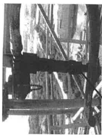
รูปที่ 4-7 ตัวอย่าง Orifice ที่ต้องทำการถอดล้าง
